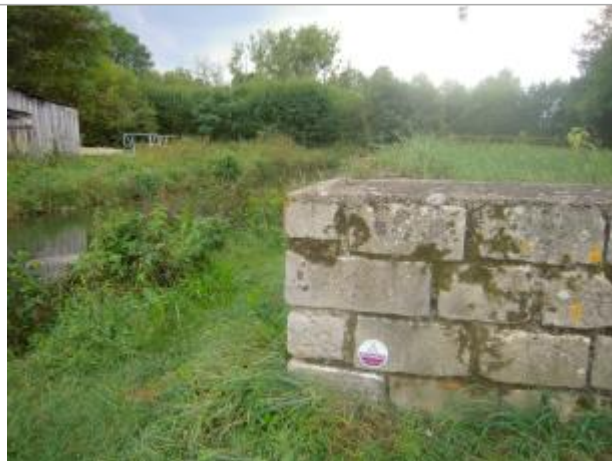
Muret au coin du chenal de la prise d'eau du canal - Photo SMBVA ©
