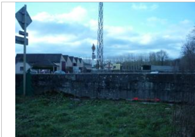
Pont RD vu de l'amont rive gauche - Photo SMBVA ©
