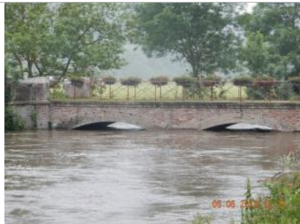
Pont à proximité de la route de la Mairie (photo SPC SACN)
