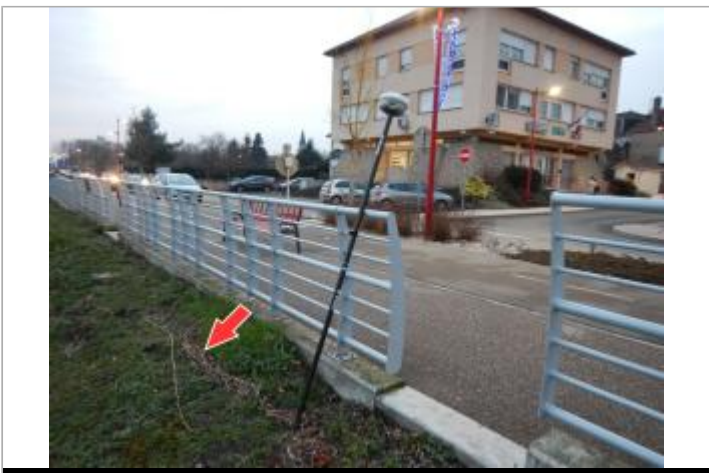
Site et repère de la crue de janvier 2018
