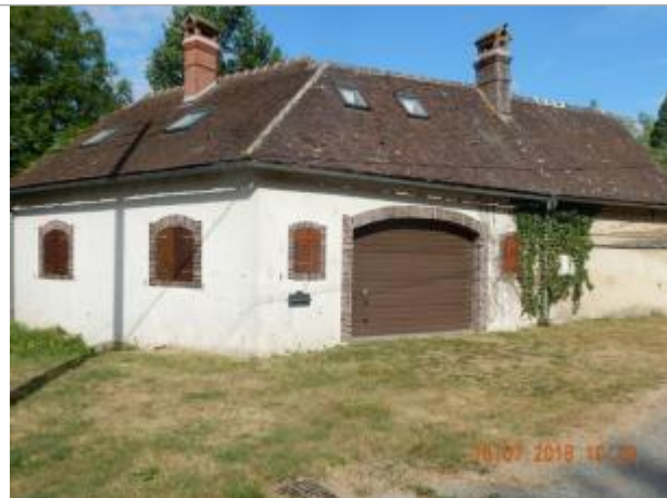
Bâtiment derrière la petite Mairie (photo SPC SACN)
