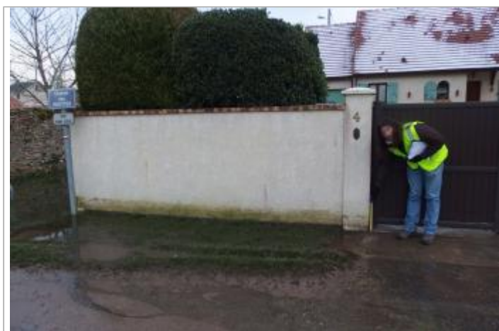
Vue du site - Auteur : SPC SMYL
