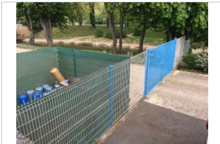
Vue du site - Auteur : SPC SMYL
