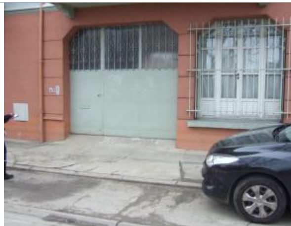
Vue du site - Auteur : SPC SMYL
