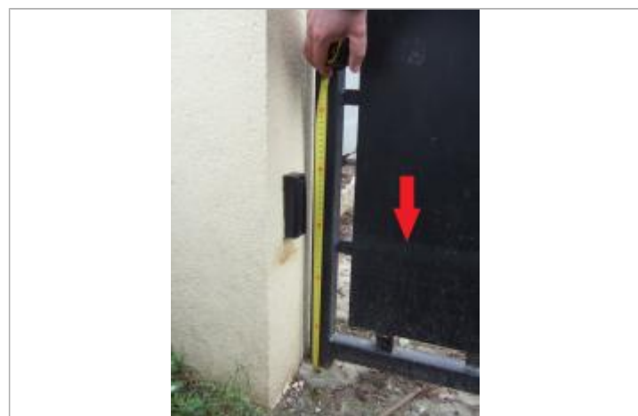
Vue de la laisse - Auteur : SPC SMYL
