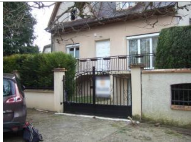
Vue du site - Auteur : SPC SMYL
