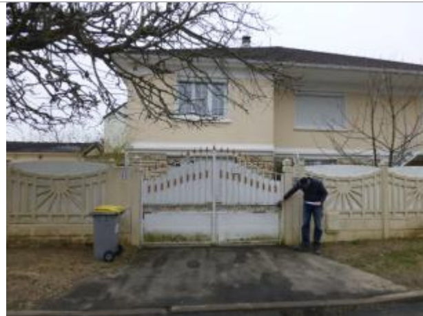
Vue du site - Auteur : SPC SMYL
