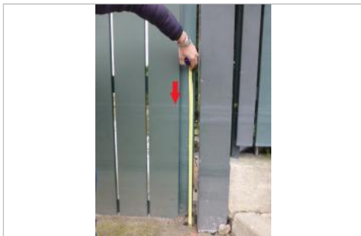
Vue de la laisse - Auteur : SPC SMYL
