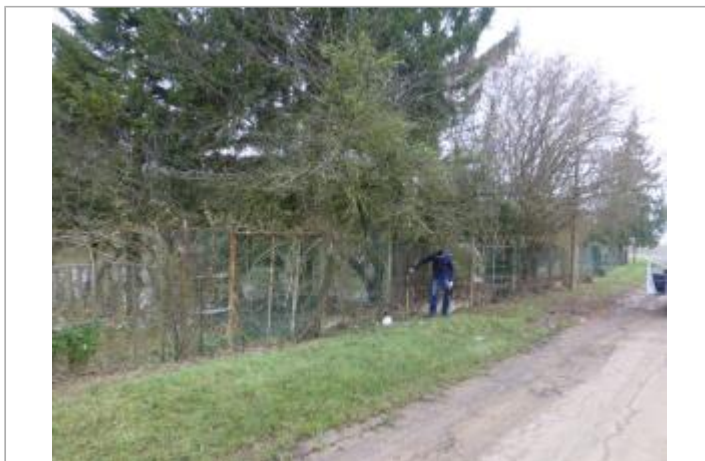
Vue du site - Auteur : SPC SMYL
