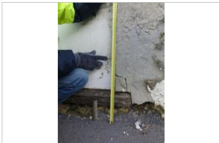
Vue de la laisse - Auteur : SPC SMYL
