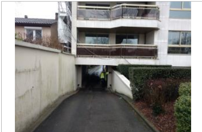
Vue du site - Auteur : SPC SMYL
