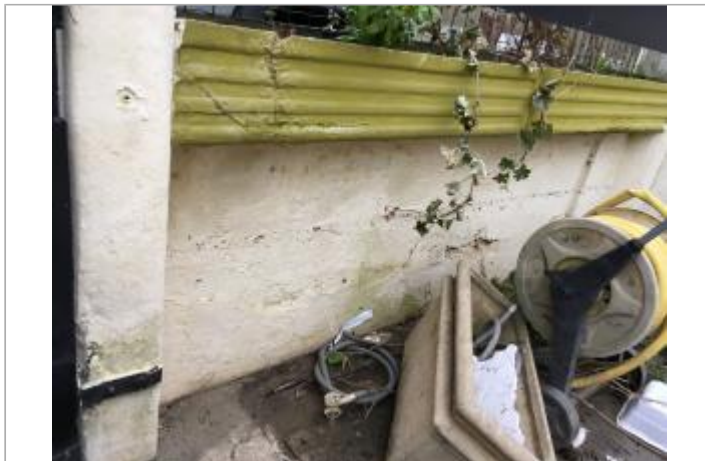
Vue du site - Auteur : SPC SMYL
