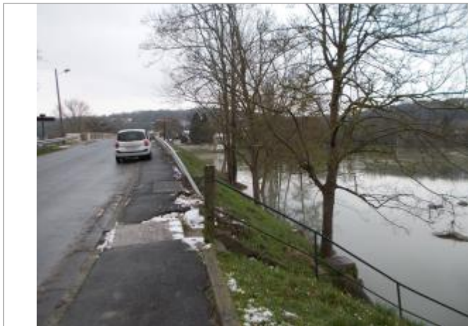
Vue du site - Auteur : SPC SMYL
