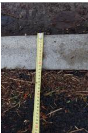
Vue de la laisse - Auteur : SPC SMYL
