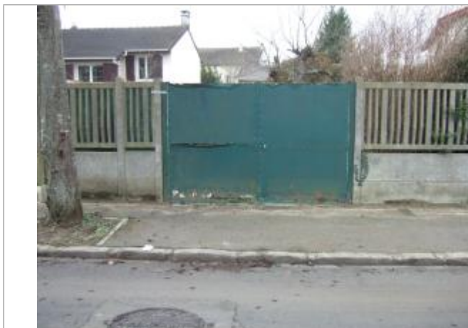
Vue du site - Auteur : SPC SMYL
