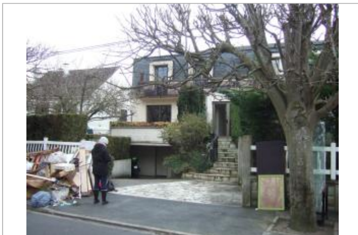
Vue du site - Auteur : SPC SMYL
