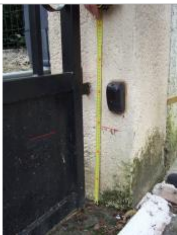
Vue de la laisse - Auteur : SPC SMYL
