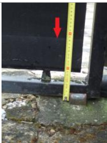
Vue de la laisse - Auteur : SPC SMYL
