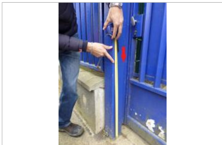
Vue de la laisse - Auteur : SPC SMYL
