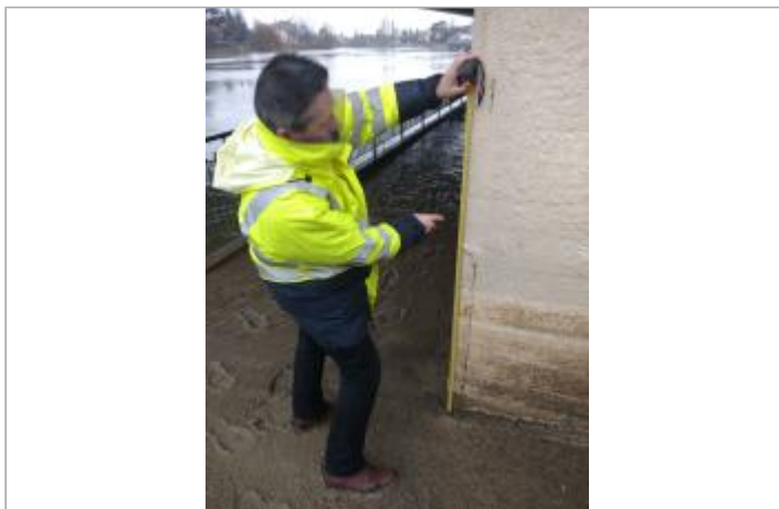
Vue du site - Auteur : SPC SMYL
