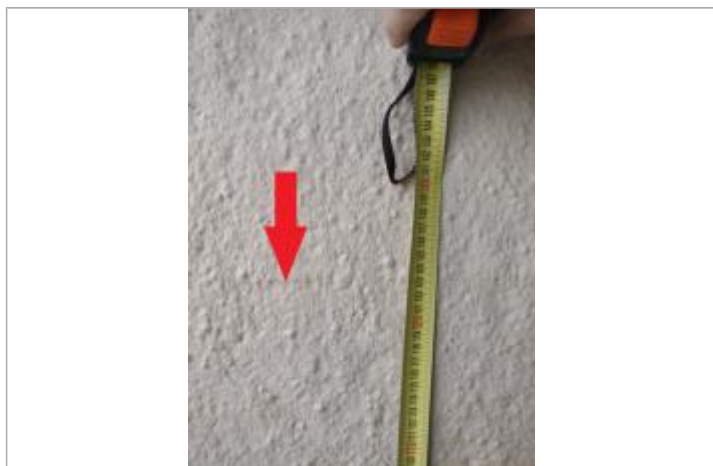
Vue de la laisse - Auteur : SPC SMYL
