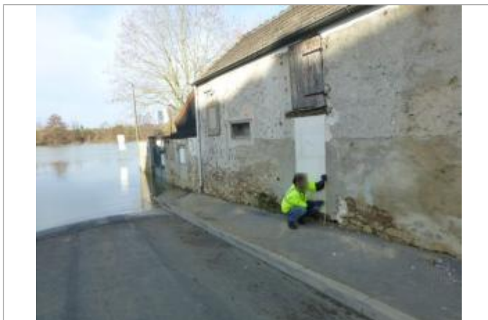
Vue du site - Auteur : SPC SMYL
