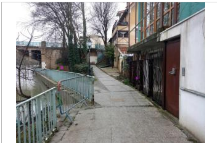
Vue du site - Auteur : SPC SMYL
