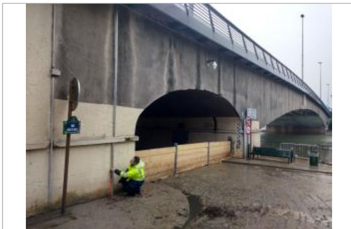
Vue du site - Auteur : SPC SMYL
