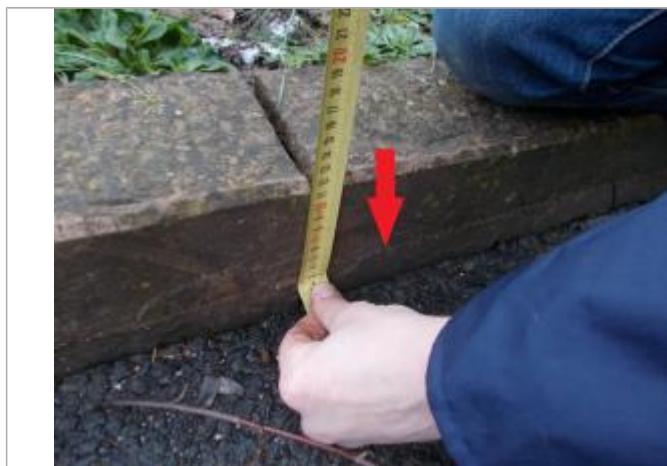
Vue de la laisse - Auteur : SPC SMYL
