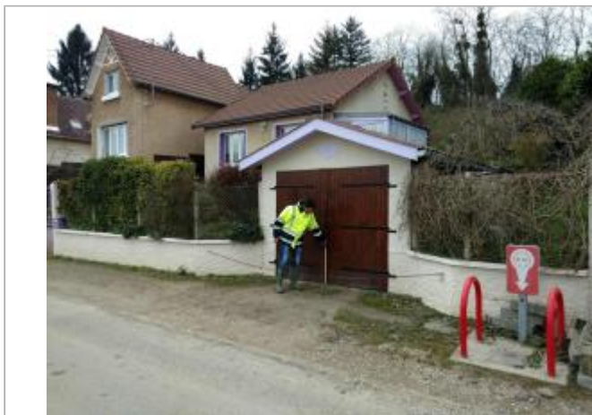
Vue du site - Auteur : SPC SMYL
