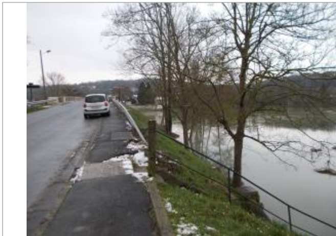
Vue du site - Auteur : SPC SMYL
