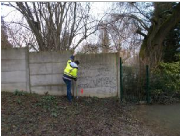
Vue de la laisse - Auteur : SPC SMYL
