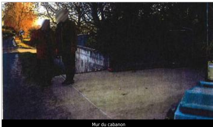
Mur du cabanon
