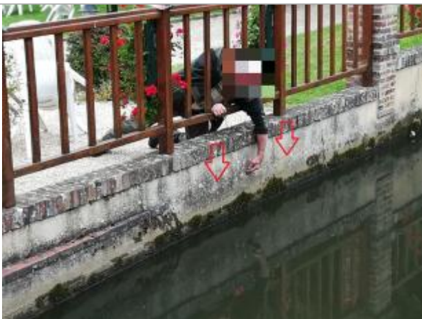
Traces laissées par l'inondation (photo SPC SACN)
