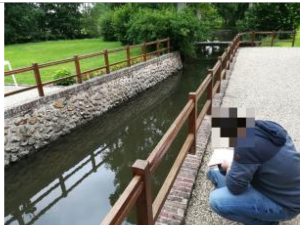
Bras usinier de l'Avre à l'aval du vannage (photo SPC SACN)
