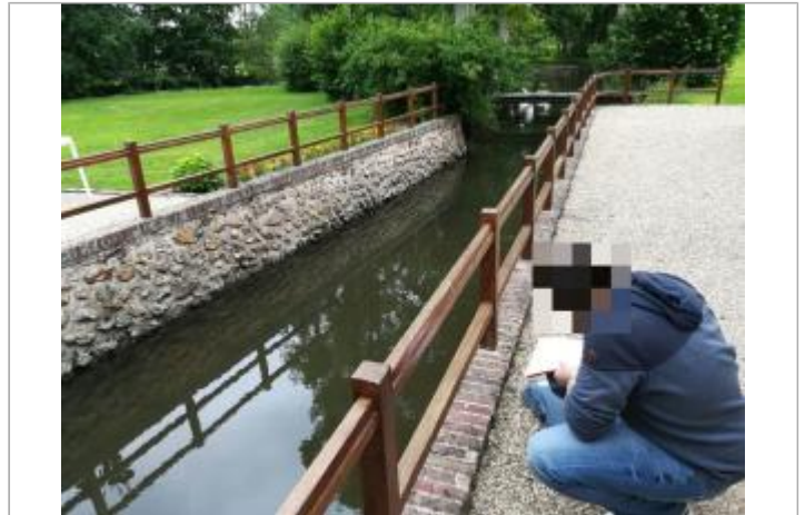
Bras usinier de l'Avre à l'aval du vannage (photo SPC SACN)
