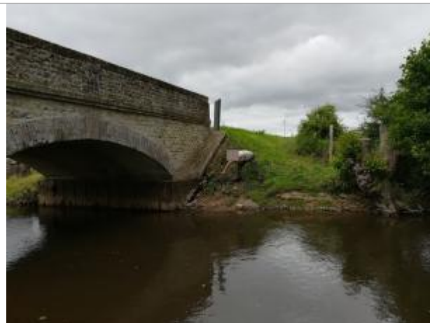
A l'aval du pont de la RD571 (photo SPC SACN)
