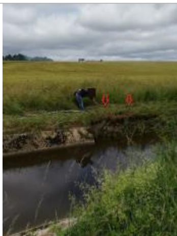
Dépôts de débris laissés par la crue (photo SIVA)
