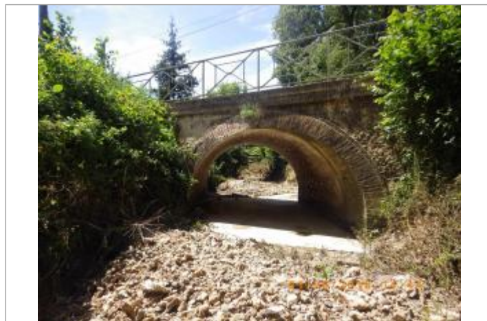
Vue sur le pont depuis l'aval (source: SPC SACN)
