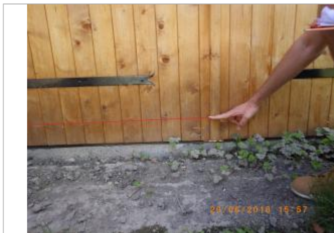
Niveau atteint matérialisé par le trait rouge, environ 10 cm au-dessus du sol (source : SPC SACN)
