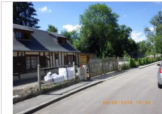
Vue du site depuis la rue de Campigny (source : SPC SACN)
