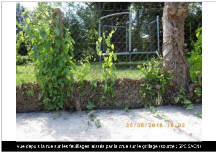
Vue depuis la rue sur les feuillages laissés par la crue sur le grillage (source : SPC SACN)
