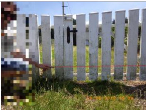
Niveau d'eau atteint matérialisé par la main et la ligne rouge (source : SPC SACN)
