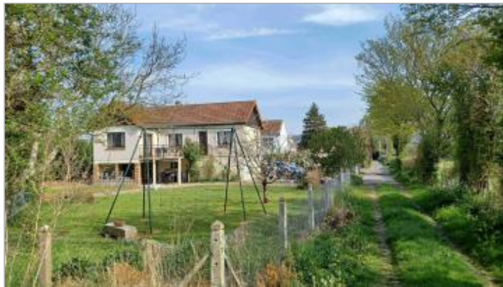
Marche de l'escalier extérieur de la maison au 3 Moulin de la Mouche
