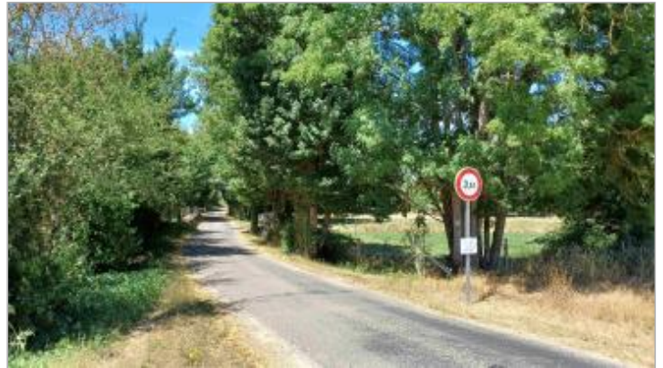
Clôture en face de la passerelle piétonne, route des Prés de la Sabotière.
