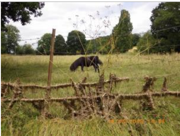
Marque d'inondation sur la clôture, légèrement au-dessus du deuxième fil barbelé, matérialisée par le niveau atteint sur la tige (source : SPC SACN)
