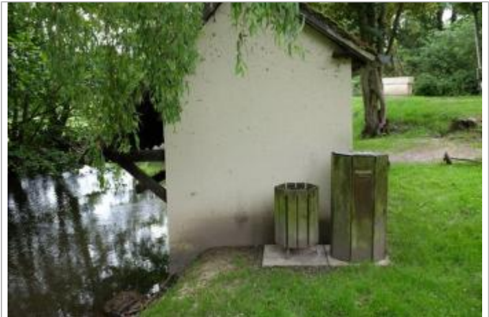
vue côté du lavoir (photo SPC SACN)
