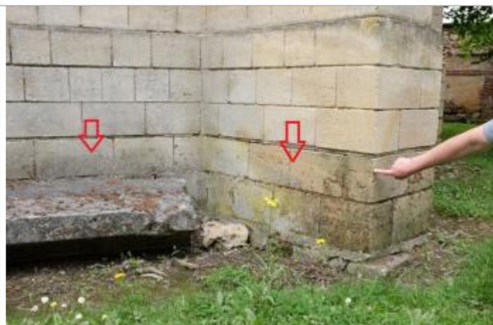
brindilles et aiguilles de pin laissées par l'inondation (photo SPC SACN)
