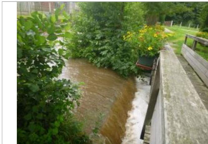
L'eau a surversé environ 15 à 20 cm au-dessus du seuil (source : Syndicat de la Risle ornaise)
