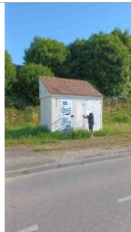
Transformateur Rue Charles Mérouvel (source : SPC SACN)
