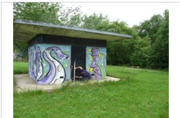
Trace sur la porte du bloc WC
