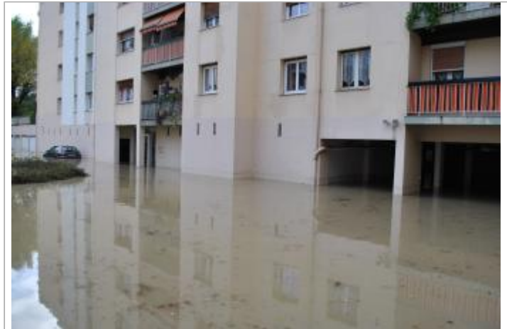
Vue générale du parking de la copropriété inondé
